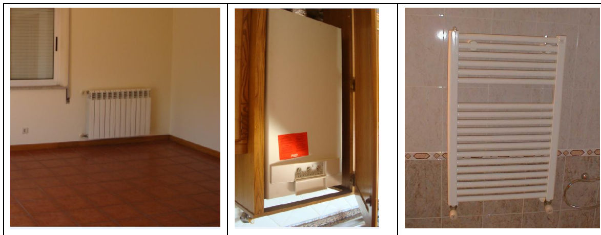
Figura 4.37 – Sistema de aquecimento e preparação de AQS de um edifício existente, 2006
