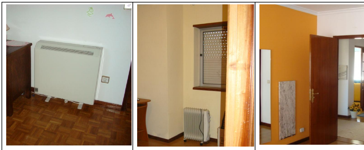
Figura 4.38 – Sistemas de aquecimento a eletricidade, edifícios da década de 1990
