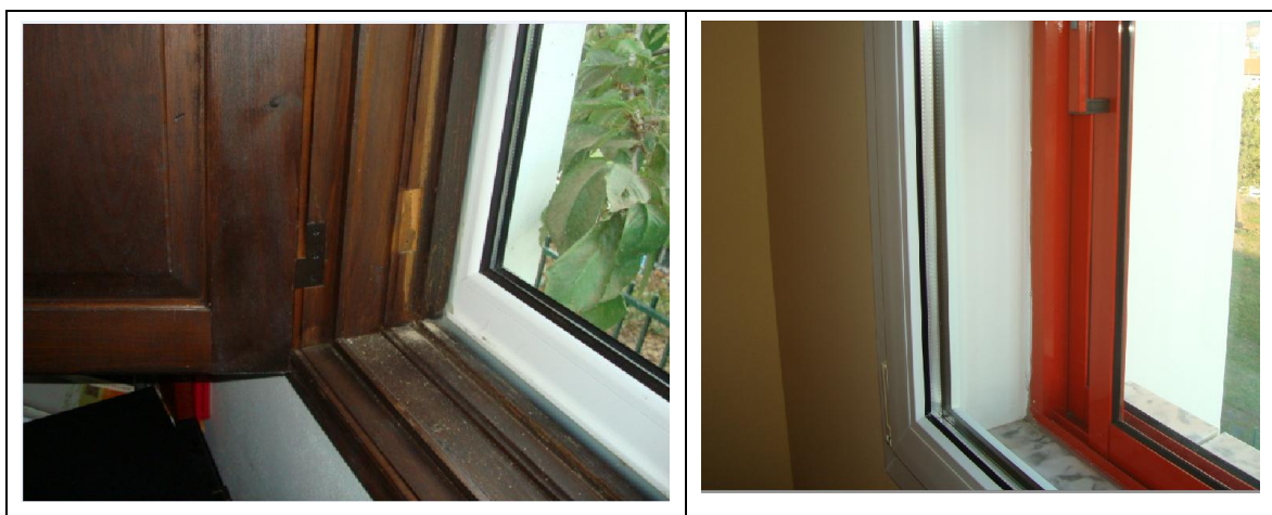
Figura 4.46 – Exemplos de reabilitação de caixilharia (edifícios anteriores à aplicação do RCCTE-1990)
