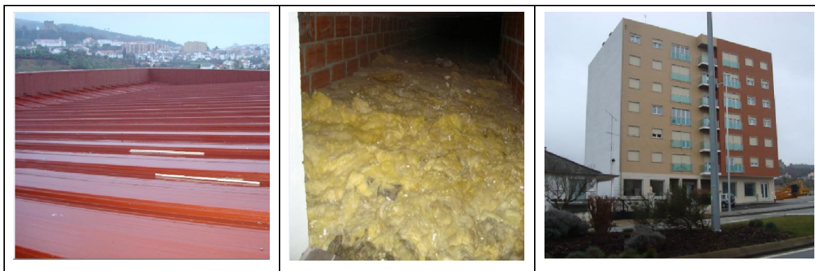
Figura 4.17 – Isolamento térmico no desvão de cobertura (rematada com platibanda) de um edifício multifamiliar construído em 2007
