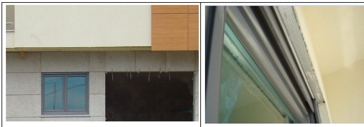
Figura 4.12 – Exemplos de aplicação do sistema ETIC's e fachada ventilada, edifício construído em 2008
