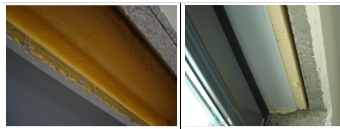
Figura 4.25 – Soluções de isolamento de caixas de estores de um edifício construído em 2008
