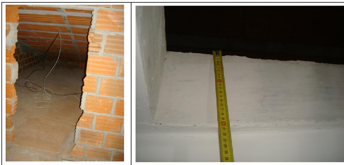
Figura 4.16 – Exemplos de soluções de desvãos de coberturas, sem qualquer isolamento térmico
