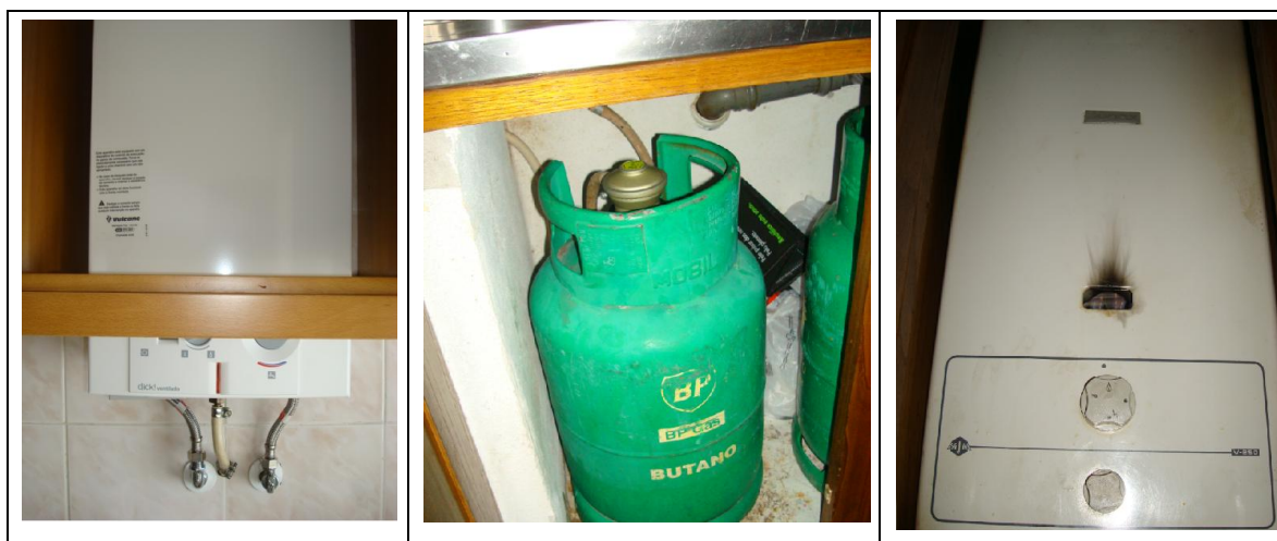
Figura 4.39 – Sistema de produção de AQS, edifícios da década de 1990
