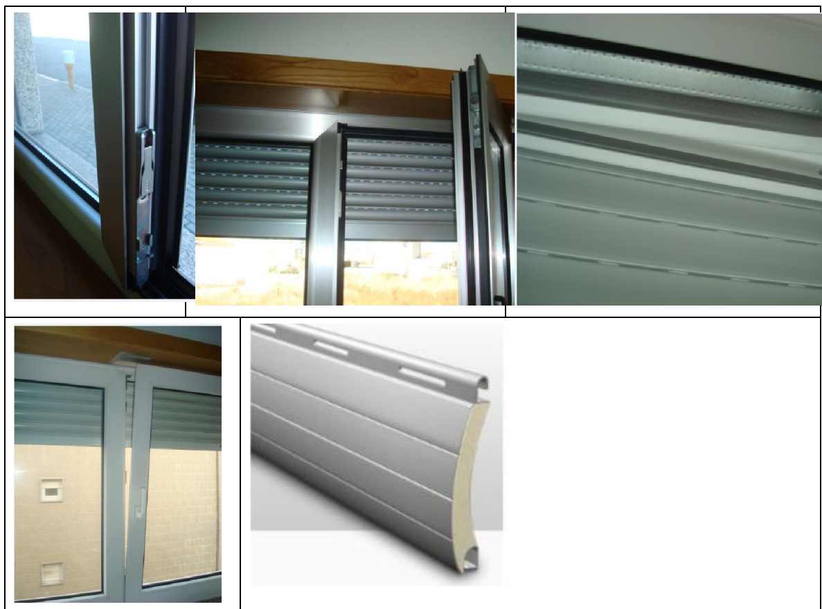
Figura 4.28 – Exemplos de soluções de vãos envidraçados com caixilharia alumínio com corte térmico, PVC, vidro duplo e persiana térmica
