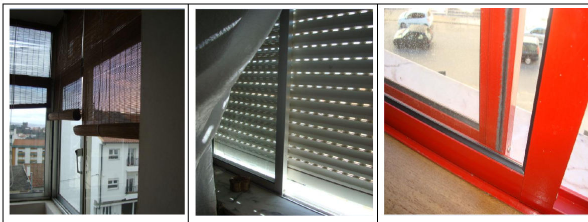
Figura 4.27 – Exemplos de soluções de vãos envidraçados, em edifícios da década de 1980, anteriores ao RCCTE-1990
