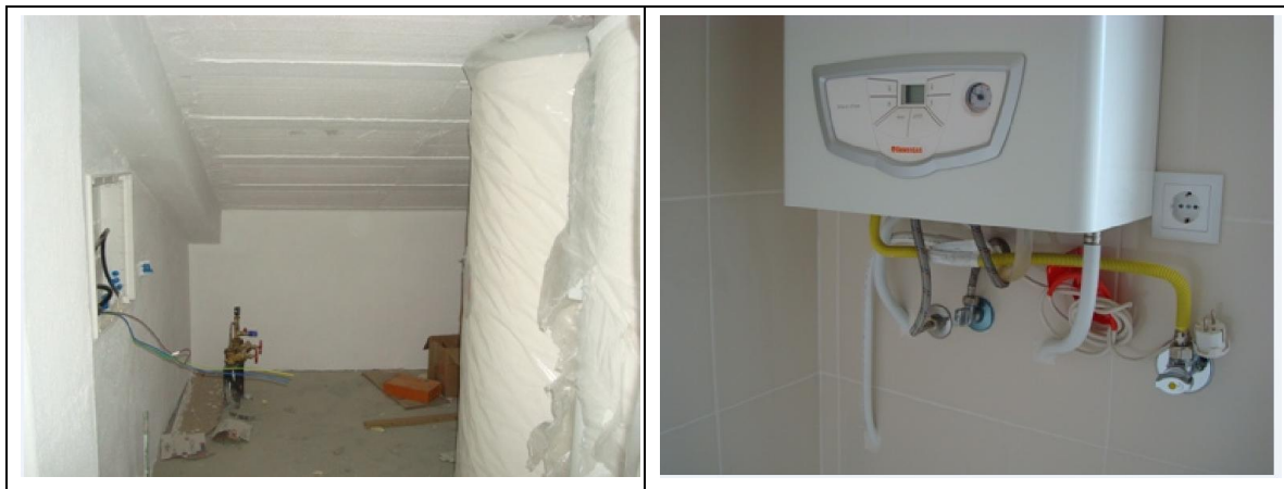
Figura 4.42 – Depósitos acumuladores, caldeira de apoio e descrição do funcionamento do sistema solar identificado num edifício inspecionado, construído em 2010
