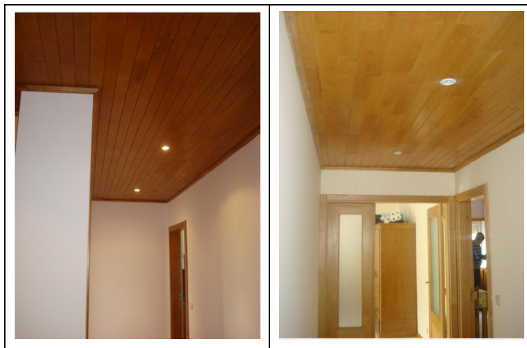
Figura 4.36 – Soluções de revestimentos em edifícios existentes que inviabilizavam a consideração de Inércia forte
