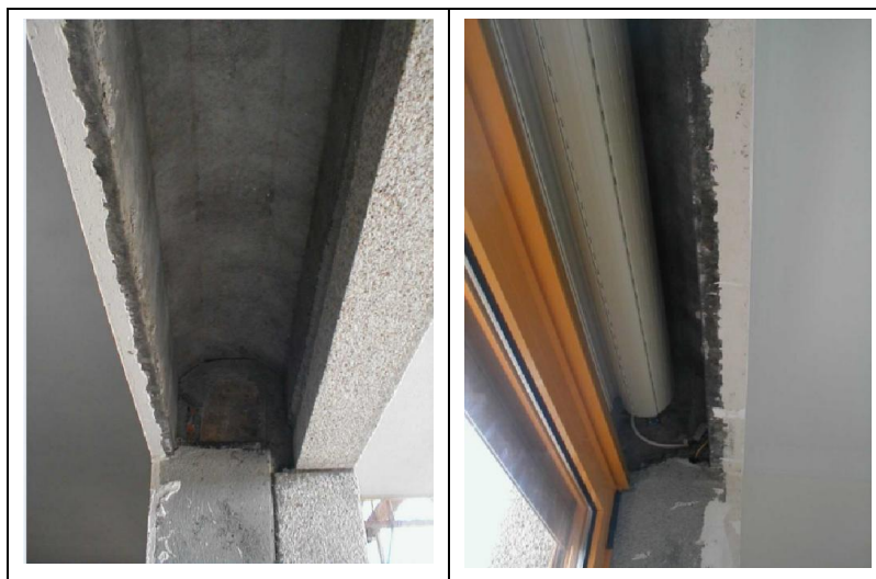
Figura 4.24 – Soluções de caixas de estores de um edifício construído em 2001
