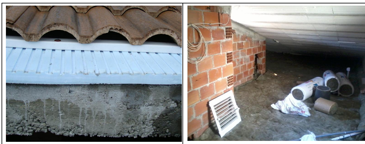
Figura 4.18 – Isolamento térmico aplicado sobre a cobertura de um edifício multifamiliar construído em 2008 (à esquerda) e aplicado sobre a laje de esteira de um edifício unifamiliar, 2010 (à direita)
